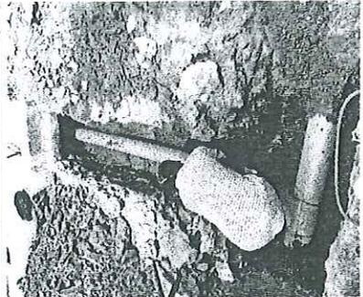
**TALC1-200** SUMINISTRO, TENDIDO E INSTALACION DE TUBERIA DE PVC PARA ALCANTARILLADO SANITARIO DE 8" (200 mm) DE Ø SERIE-20, CON CAMPANA Y EMPAQUE, INCLUYE: ADQUISICION, ACARREO AL LUGAR DE LA OBRA, HERRAMIENTAS Y PRUEBAS.
